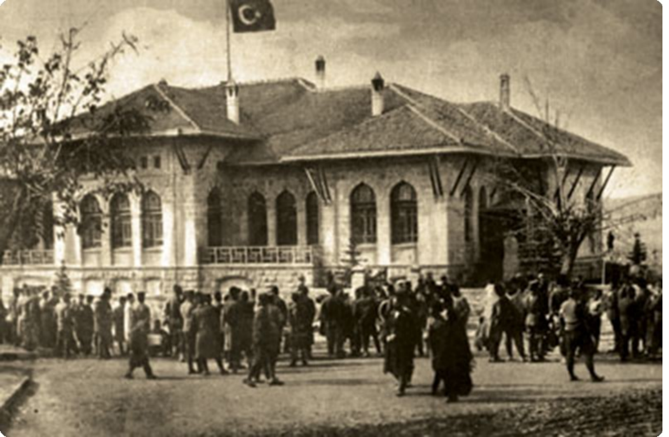
I Türkiyə Böyük Millət Məclisi binası
