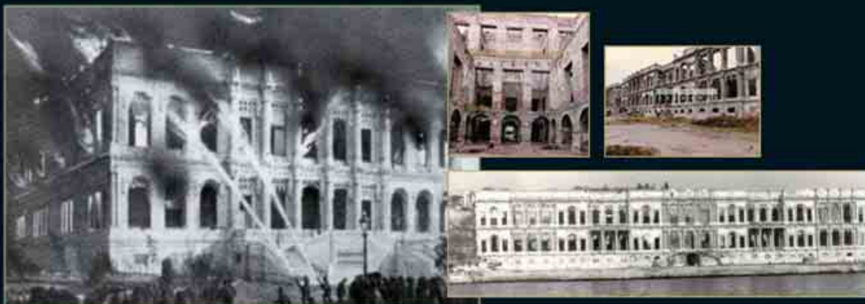
Le Palais Ciragan à Istanbul après l'incendie et la destruction de son intérieur et de sa décoration. Dans cet état, le palais ne permet pas de représenter pleinement la magnificence de son intérieur jadis.
