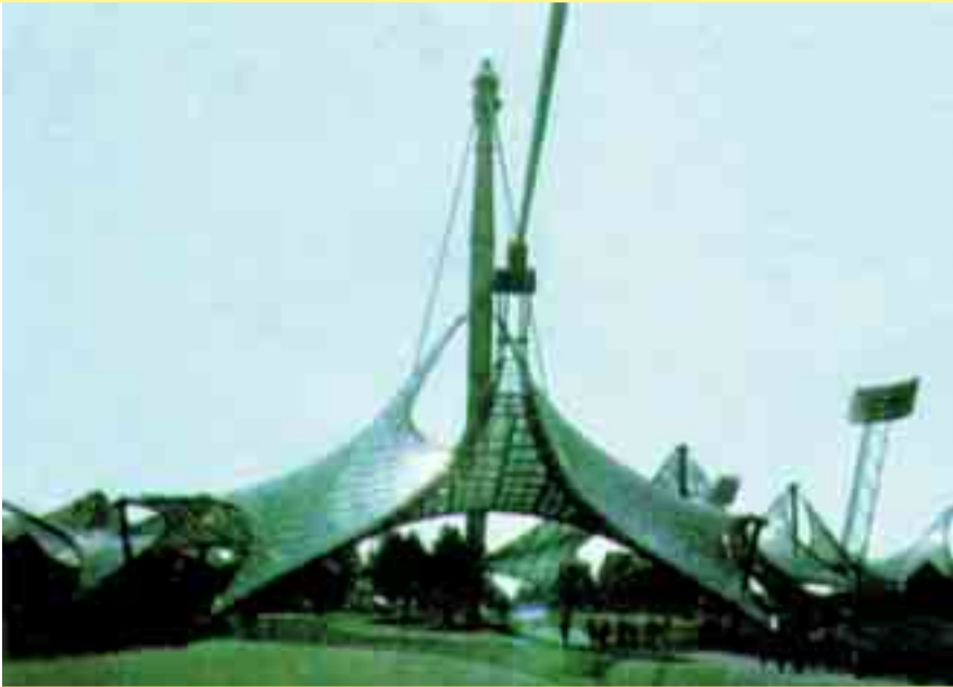
Münih Olimpiyat Stadı'nın tavanı, örümceğin ağından esinlenerek yapılmıştır. Böylece tavadaki çeşitli gerilimler eşit olarak dağıtılmıştır.
